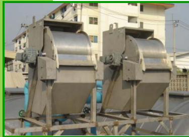
เครื่องตักขยะละเวียดแบบดรัม (Drum Screen)
