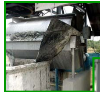
เครื่องตักขยะละเวียดแบบดรัม (Drum Screen)
