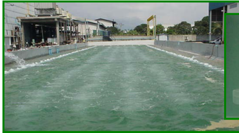
เครื่องเติมอากาศแบบหัวกระจายอากาศใต้น้ำ (Diffuser)
