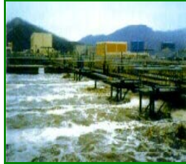
เครื่องเติมอากาศแบบหมุนใต้น้ำ (Submersible Aerator)
