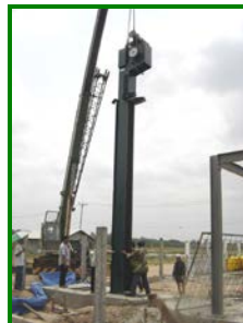
งานติดตั้ง Automatic Fine Screen มหาวิทยาลัยขอนแก่น
