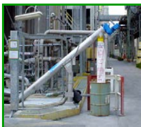
เครื่องตักขยะแบบสกรู (Screw Screen)
