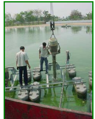
งานติดตั้ง Jet Aerator เทศบาลเมืองชะอำ
