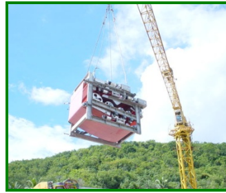
งานติดตั้ง Filter Press ศูนย์การค้าเซ็นทรัลพลาซ่า 2
