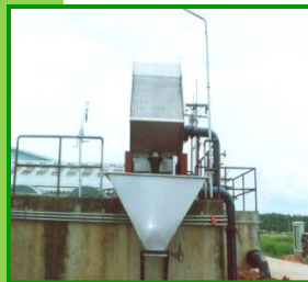
เครื่องตักขยะละเวียดแบบสแตตติค (Static Screen)
