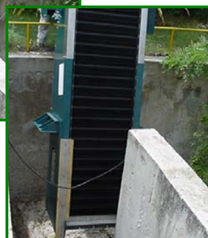
งานติดตั้ง Fine Screen Thai Kraft, Karnchanaburi
