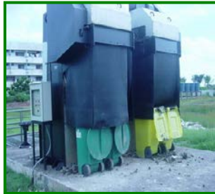
งานซ่อม Fine Screen ในระบบบำบัดน้ำเสีย
