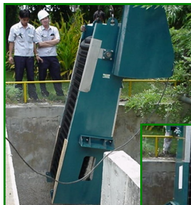
งานติดตั้ง Fine Screen Thai Kraft, Karnchanaburi
