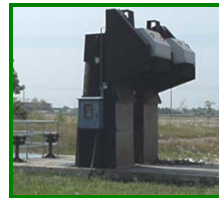
งานซ่อม Fine Screen ในระบบบำบัดน้ำเสีย
