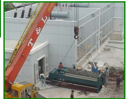
งานติดตั้ง Filter Press ศูนย์การค้าเซ็นทรัลพลาซ่า 2
